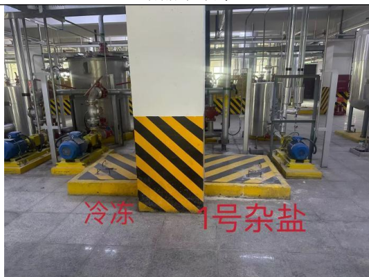
冷冻、1#杂盐事故水池
