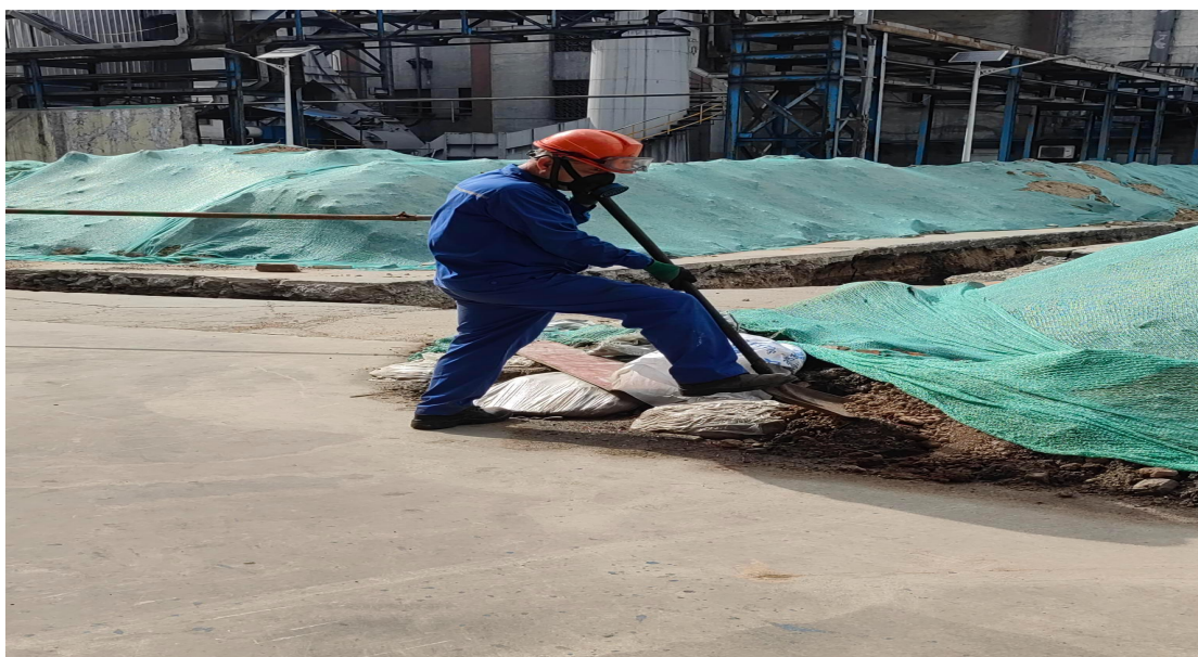
⑤当班人员对四万方脱硫门口使用土进行封堵，防止脱硫液外渗
