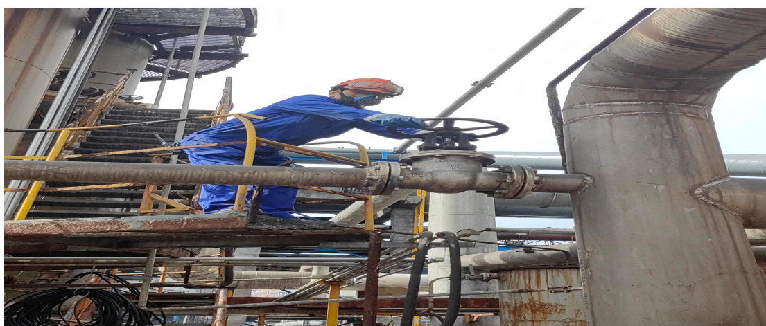
②当班操作人员发现漏点后，佩戴长管式呼吸器对漏点部位进行确认
