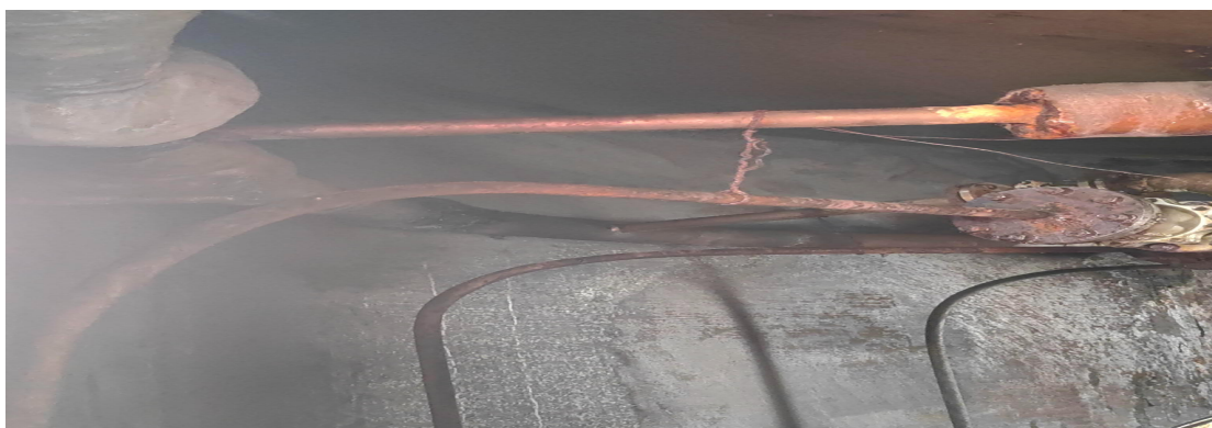
④当班人员安装轴流风扇向槽罐底部送风，为检修前做准备
