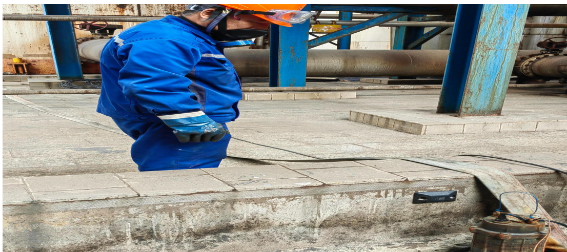
⑥将多余的脱硫液抽至二级脱硫槽罐内
