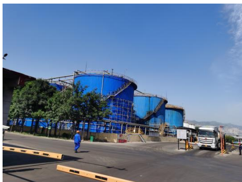
焦油工序原料槽区
