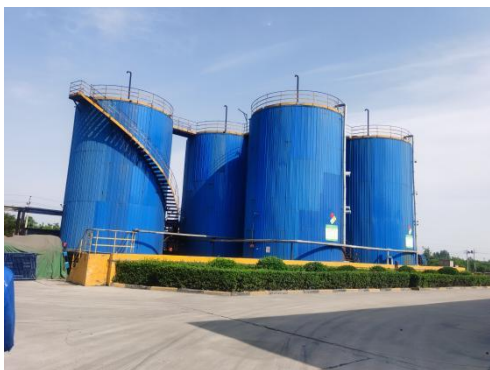
2-萘酚工序酸碱罐区
