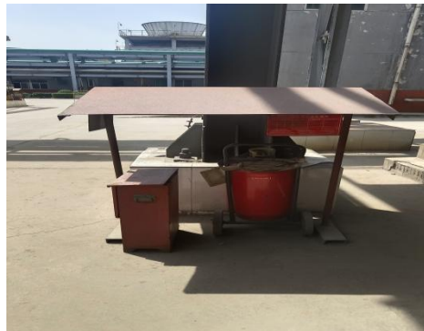
精蒽工序消防器材
