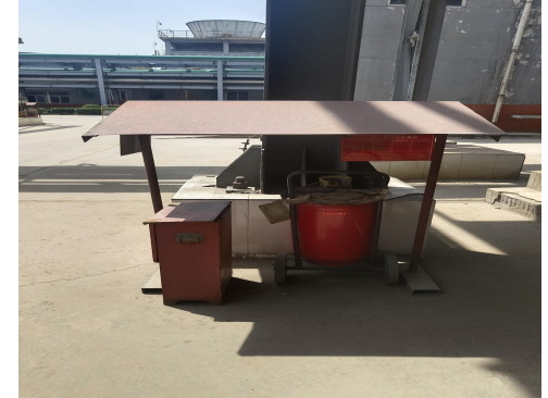
精蒽工序消防器材
