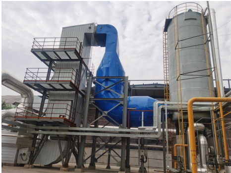
炭微球工序导热油炉
