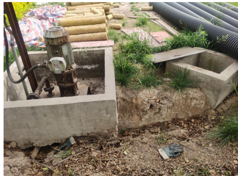
化工厂初期雨水池
