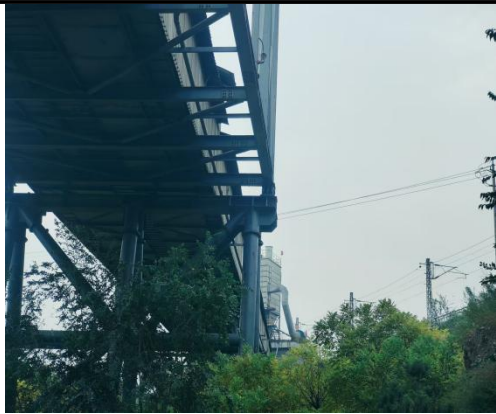
雨水排口监控设施
