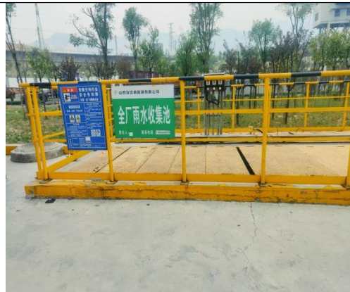
全厂雨水收集池
