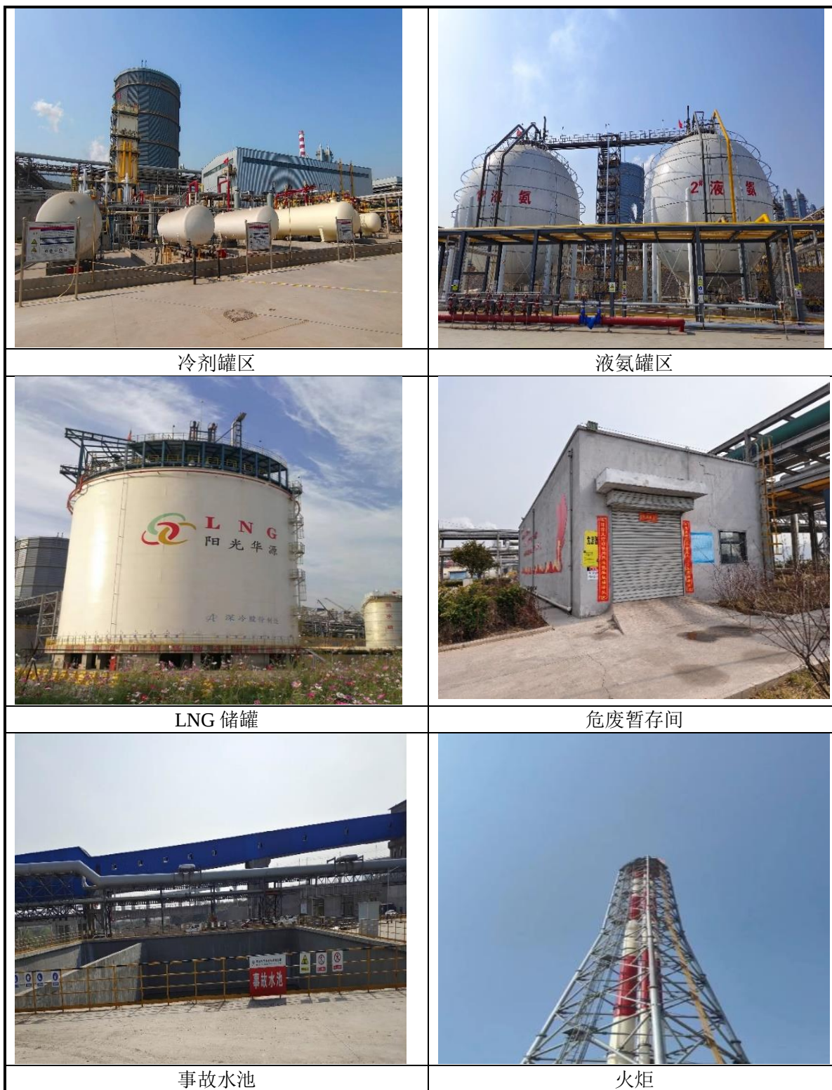
图 3.3-7 本项目依托华源现有工程设施图片
