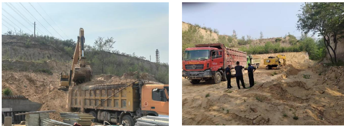
图 5.7.6-2 河津经开区事故水池施工现场图片
